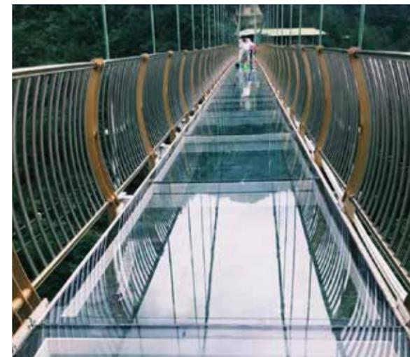
This product is made of three layers of laminated glass / Этот продукт изготовлен из трех слоев многослойного стекла.
